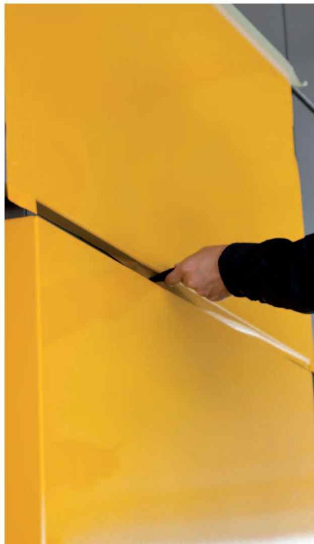
In tegenstelling tot een geschilderde verflaag is de folie overal even dik en dekkend (90 tot 115 micron) dus ook op hoeken.
