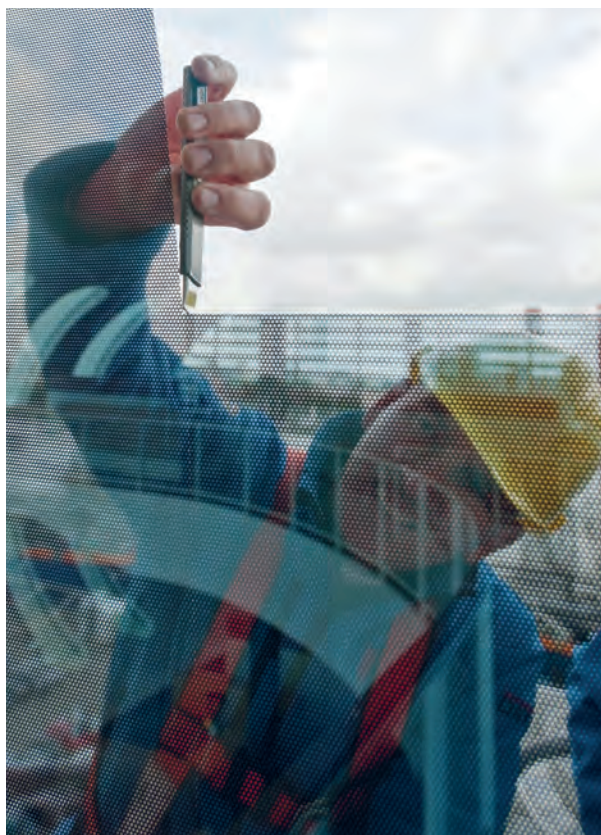
▲ Monteurs van glasfolie gebruiken meestal een 45-graden-mes. Met zo'n mes snijd je wat minder snel in de ondergrond.
